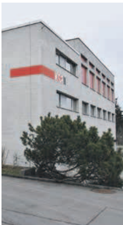
Der KSA-Standort in Nuolen. Bild Archiv
